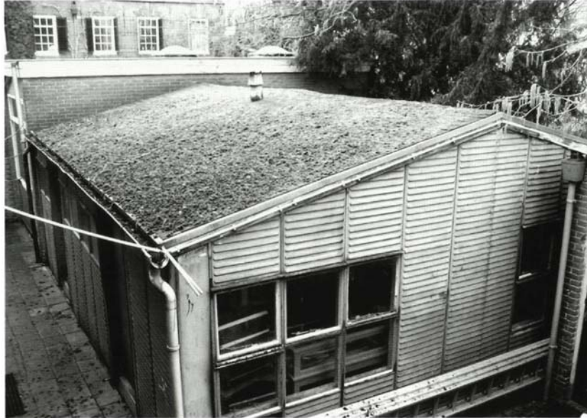
Overzicht van de barak. Coll. architectenbureau Veldman & Rietbroek / bureau Monumenten & Archeologie van de gemeente Leiden.
