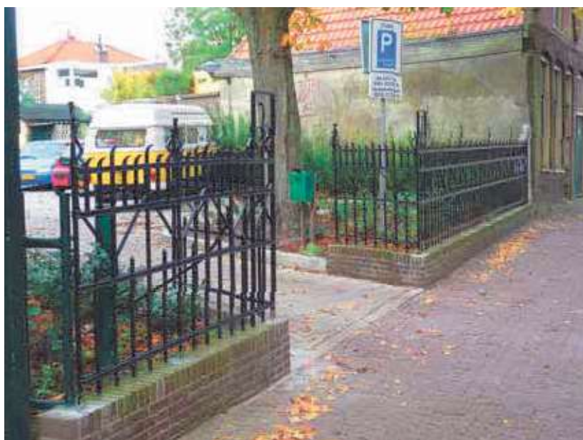
Gerestaureerd hekwerk aan het Achterom
