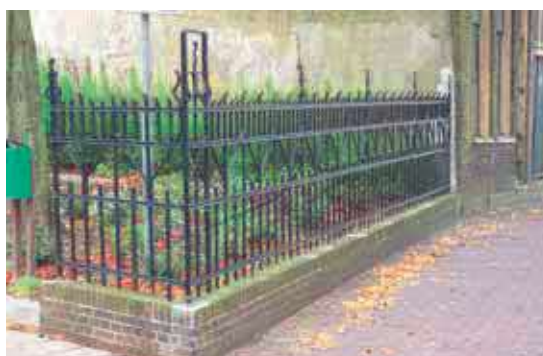
Links: situatie hekwerk voor restauratie Rechts: situatie hekwerk na restauratie
