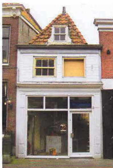
Links: voorgevel bestaande situatie Rechts: verwijderde achtergevel
