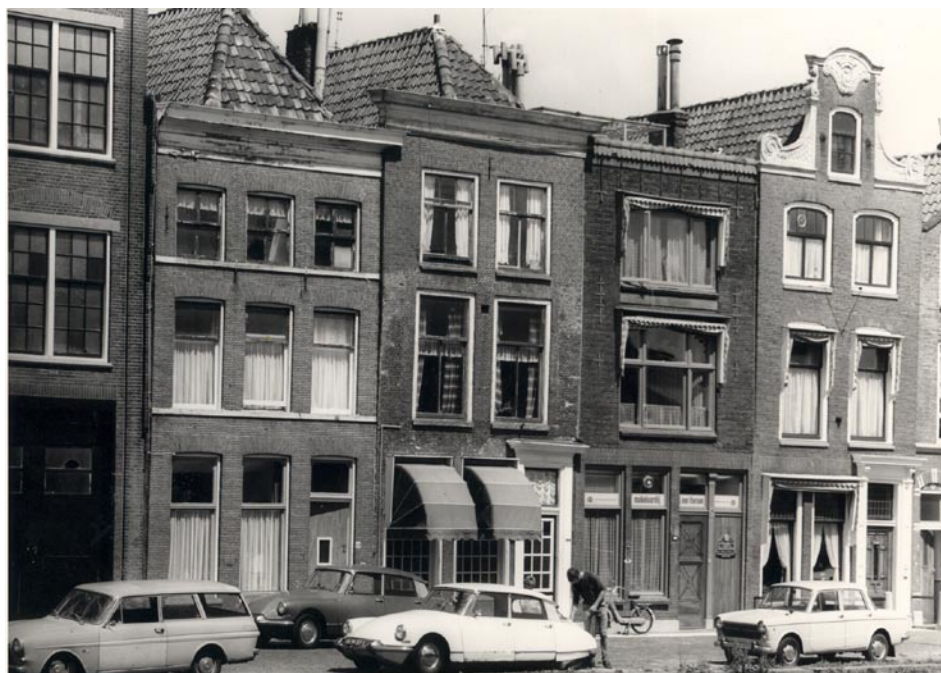
Gevel Oude Singel 184 omstreeks 1970. De roedeverdeling is nog gedeeltelijk aanwezig. Het deurkozijn heeft nog het kleine bovenlicht. (Afbeelding Bureau Monumentenzorg en Archeologie gemeente Leiden)
