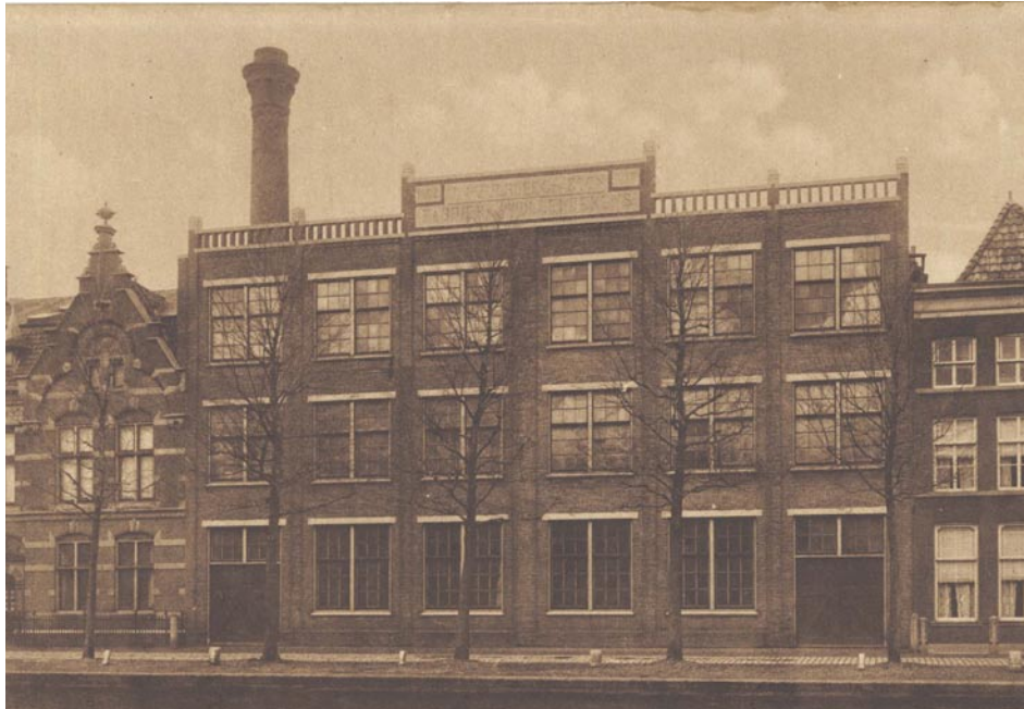
Fabriek Zuurdeeg & Zoon met gedeeltelijk Oude Singel 184 omstreeks 1920. De brede middenstijlen zijn nog aanwezig op de verdiepingen, de raamkozijnen op de begane grond zijn gewijzigd. De stoep is nog aanwezig. (Foto Regionaal Archief Leiden)
