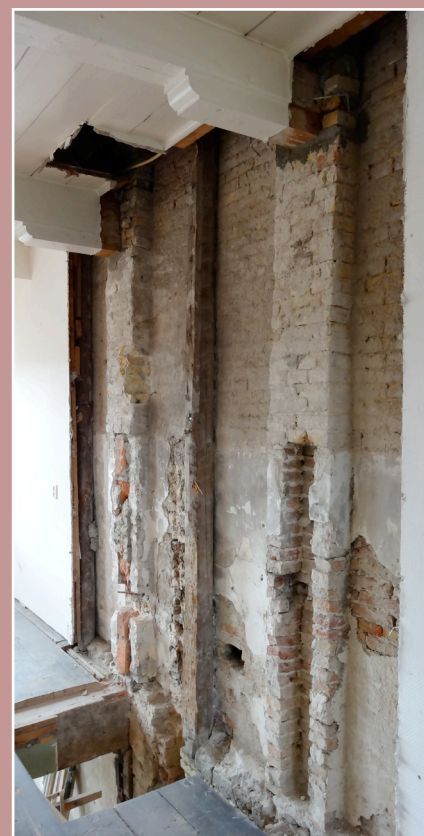
Foto omgezet muurwerk eerste verdieping met sleuven voor houten muurstijlen. Het bovenste (dichte) metselwerk is gerealiseerd bij de verhoging van het pand tijdens bouwphase III
